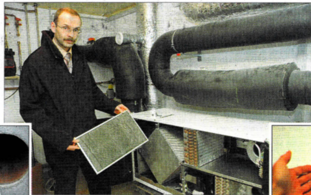
Alois Frank vor der Lüftungsanlage im Keller. In seiner Hand hält er den Pollenfilter. Das kleine Bild links zeigt das Rohr, über das die Frischluft aus dem Freien gesaugt wird. Rechts ist das Lüftungssystem im Haus zu sehen. Dort wird temperierte Luft sanft ins Haus gepustet.
